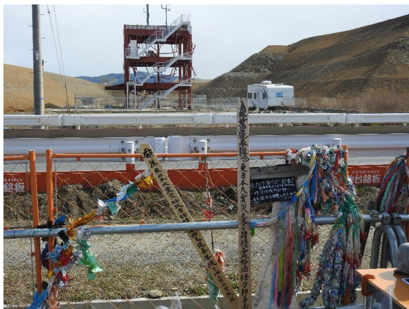
住民に最後まで非難を呼びかけながら被害を受けた 防災センター
